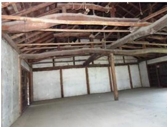
写真2 三階の様子と梁の小屋組み
